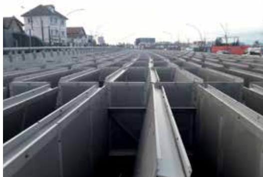
La couverture de l'autoroute A6b achevée en 2012
