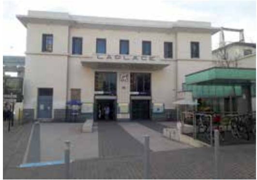
Le pôle multimodal Laplace réhabilité
